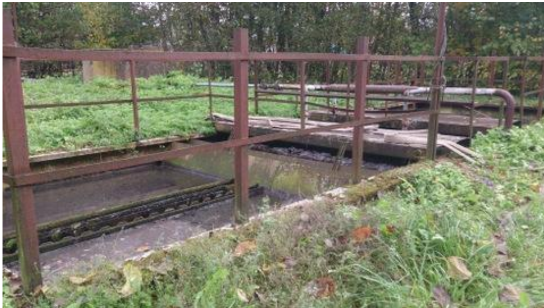
Foto 30. Vahenurme küla reoveepuhasti aeratsioonimahutid
