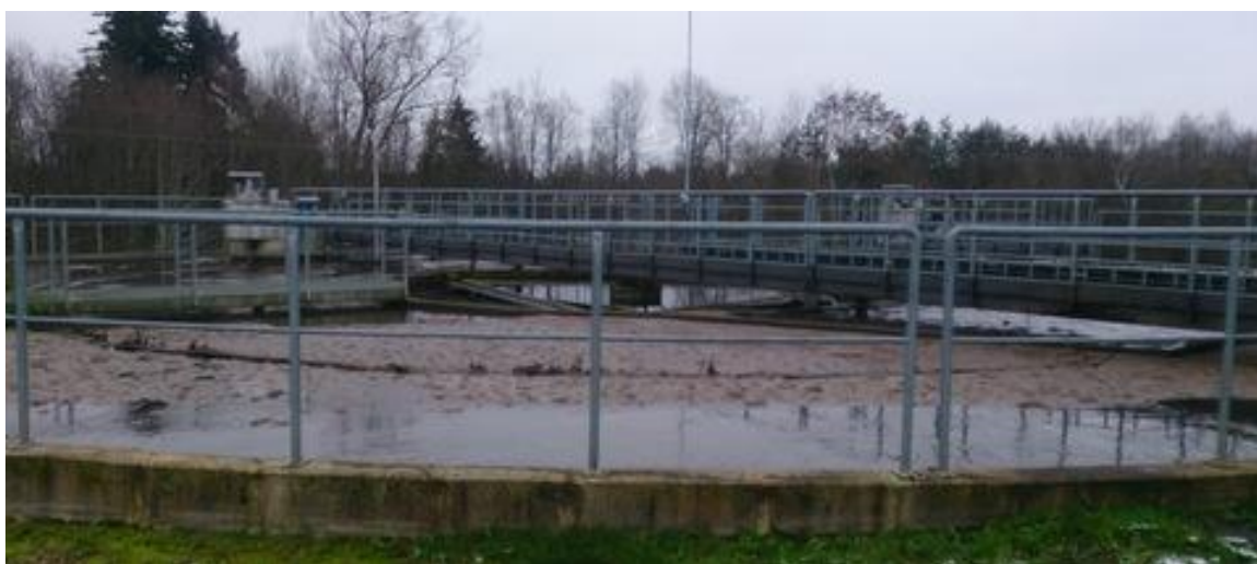
Foto 5. Vändra reoveepuhasti aeratsioonitangid
