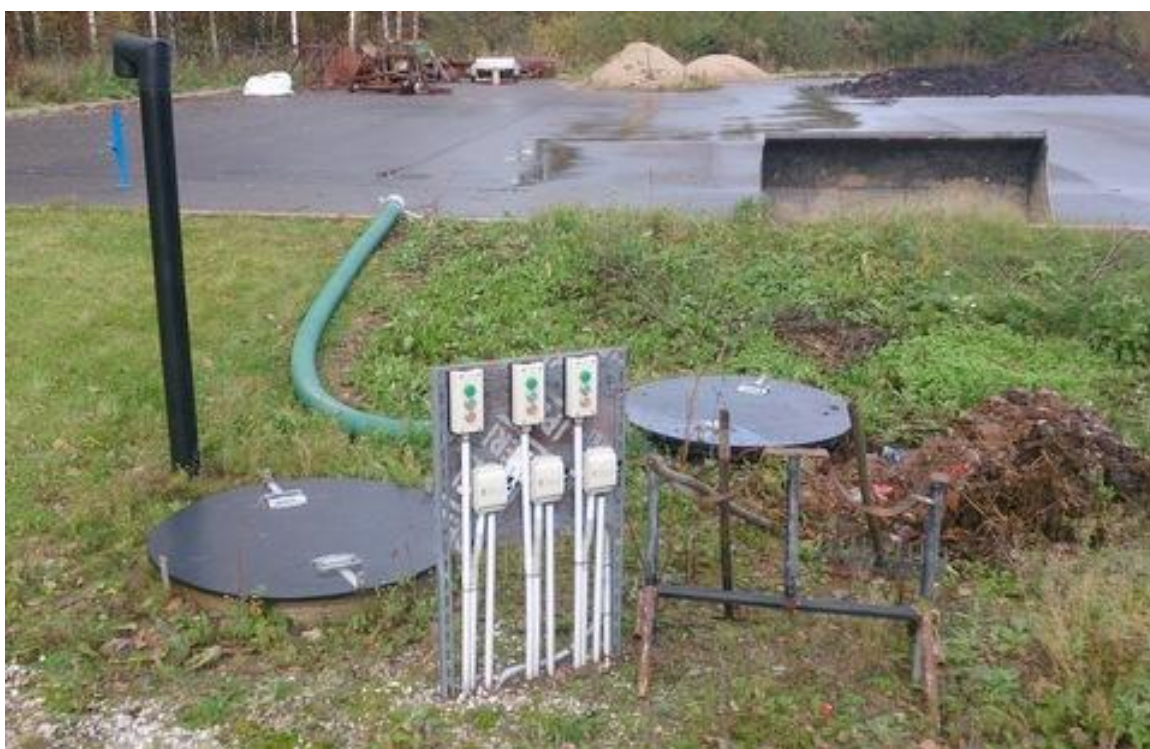
Foto 20. Purgimissõlm Pärnu-Jaagupi reoveepuhasti juures
