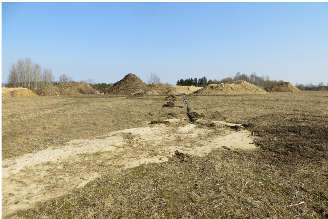
Foto 2. Kaevetööde käigus on toimunud vee väljapumpamine ning pinnasesse juhtimine. Vaade ehitusalale edela suunast (foto on tehtud 27.03.2014).
