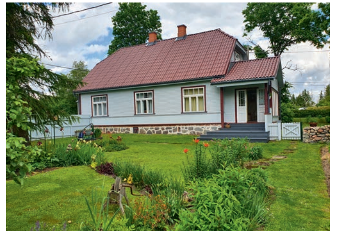
Vana tn 15 – elamud tiheasustuses II koht
