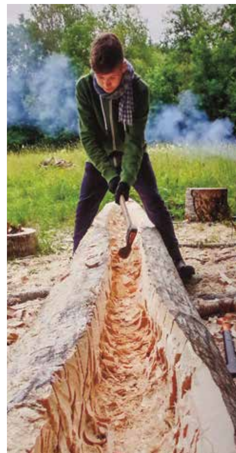
Fotol on näha haavapuu õõnestamist ühes Soomaal toimunud haabjalaagris.
