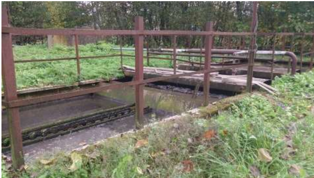
Foto 30. Vahenurme küla reoveepuhasti aeratsioonimahutid
