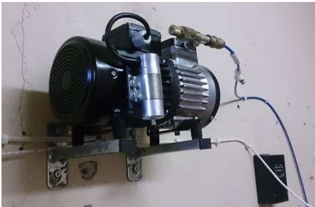
Foto 47. Kadjaste reoveepuhasti kompressor
