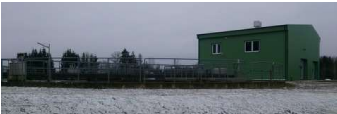
Foto 4. Vändra reoveepuhasti tehnohoone ja aeratsioonitangid
