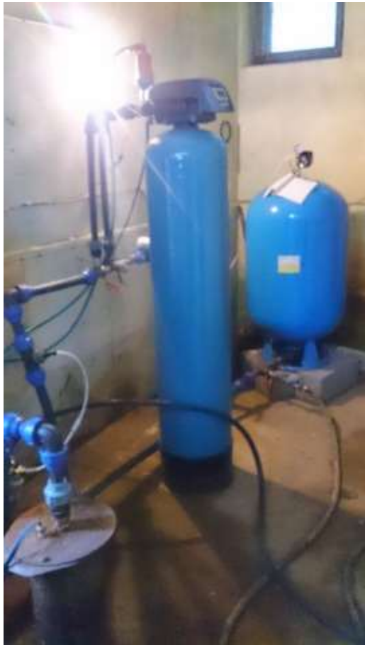
Fotod 59 ja 60. Kirikumõisa küla puurkaev-pumpla veetöötlusseade, hüdrofoor ja kompressor
