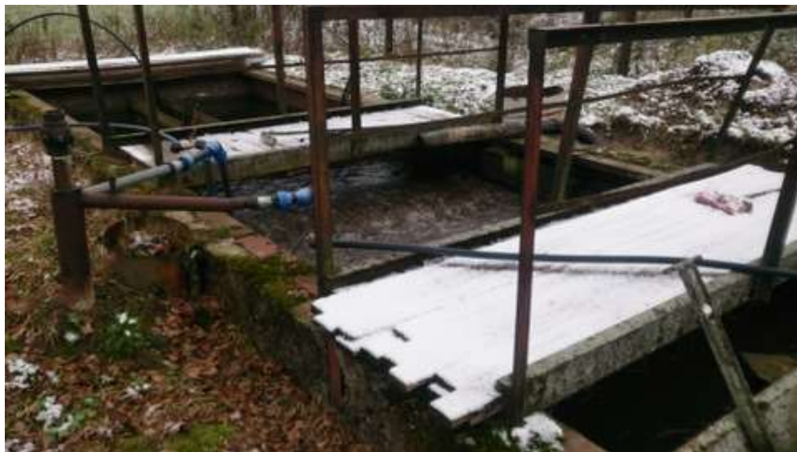
Foto 42. Suurejõe reoveepuhasti aeratsioonimahuti
