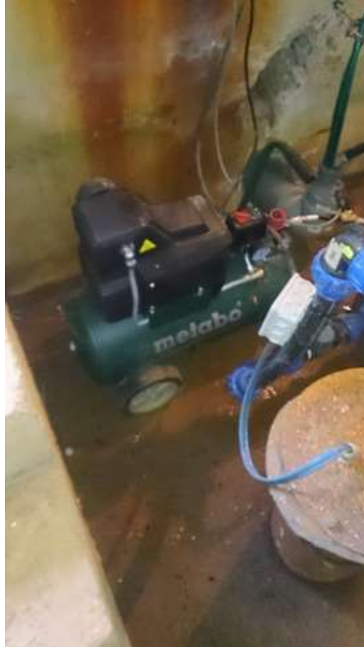
Fotod 59 ja 60. Kirikumõisa küla puurkaev-pumpla veetöötlusseade, hüdrofoor ja kompressor
