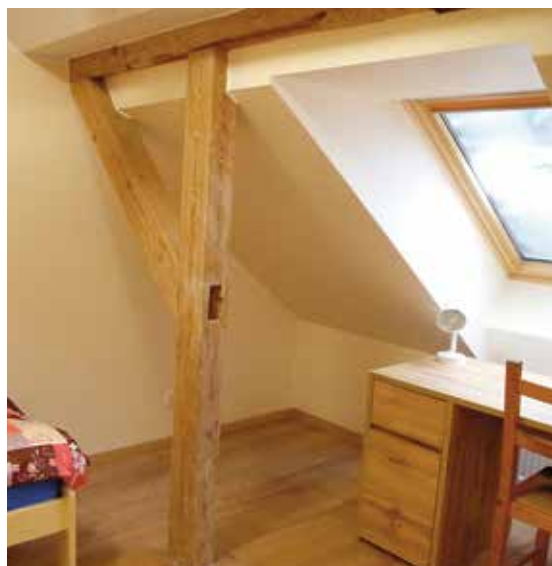
Toetatud elamise teenusel olevate klientide tubasid teisel korrusel ilmetavast säilitatud puittalad.
