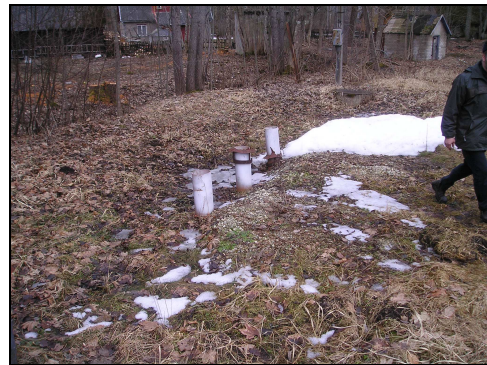
Joonis 19. Halinga turvakodu imbväljak, paremal imbväljakule eelneva septiku õhutustorud (fotod 05.04.06)
