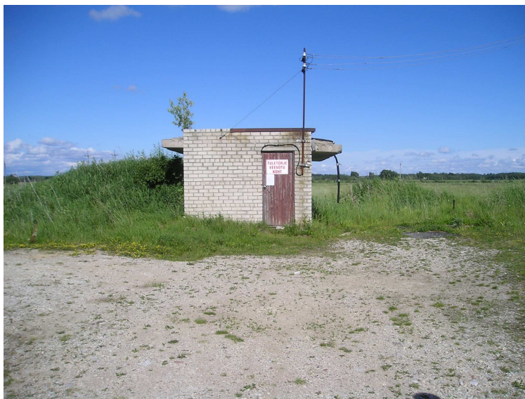
Joonis 15. AS Vahenurme Agro (kat. nr 6163) puurkaev-pumpla
